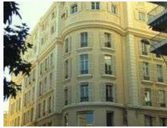
NOUVEAU BUREAU EN PLEIN CARRE D'OR
