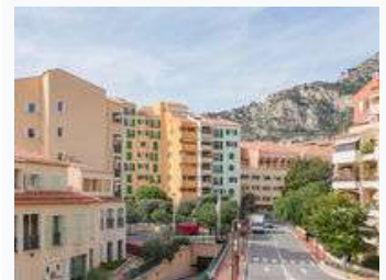
BOTTICELLI - 2 PIECES RENOVE AVEC LOGGIA
